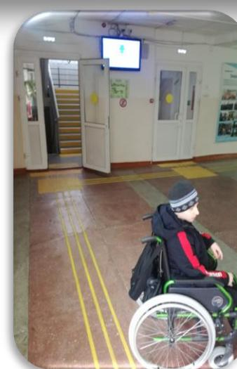
Пути перемещения внутри здания оснащены горизонтальными поручнями на путях движения второго и третьего этажа, на первом этаже оборудована тактильная предупреждающая и направляющая разметка, в наличии контрастная маркировка стеклянных дверей и ступеней лестничных маршей, кабинеты имеют таблички с обозначением аудиторий и помещений, выполненных рельефно-точечным шрифтом Брайля, на контрастном фоне.
